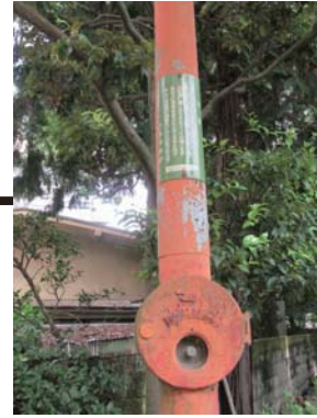
昔の火災報知器
