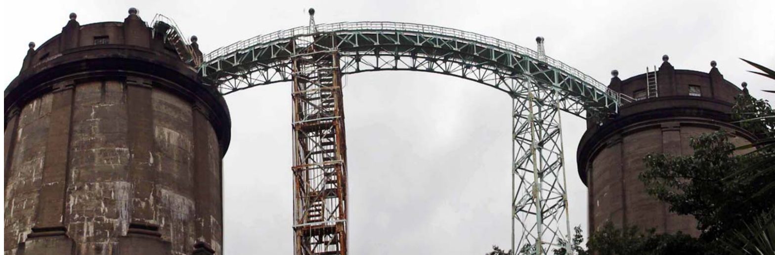
左が2号塔で右が1号塔。パノラマ撮影のためトラス橋が湾曲しています。
