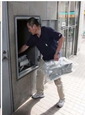
店着した新聞を地下の作業場に落とすためのシューターの口です。梱包された新聞をこのように地下へ落とします。これにより新聞を階段で地下に運ばなくて済みます。
